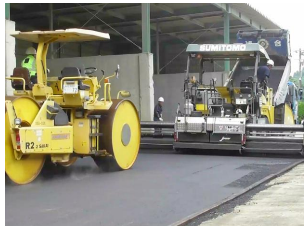
エコ・ループファルト施工状況
