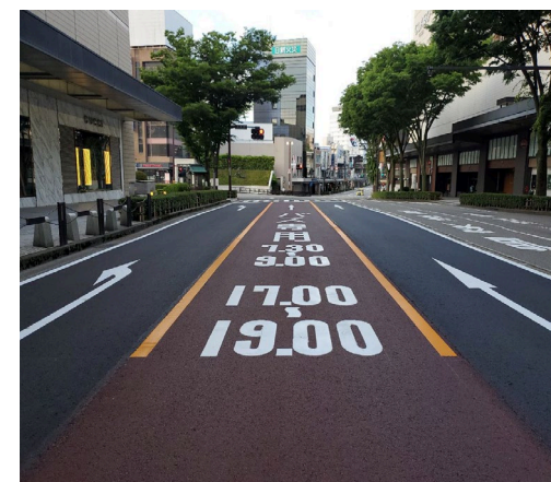
R6金沢国道維持舗装復旧工事
