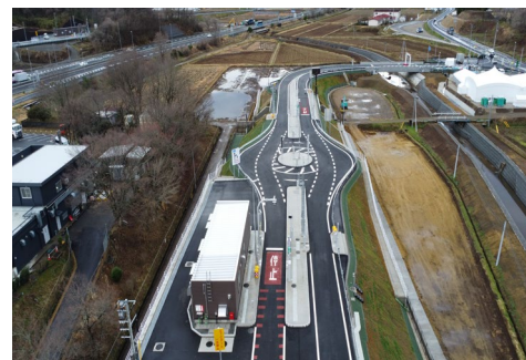
東北自動車道 菅生スマートIC舗装工事
