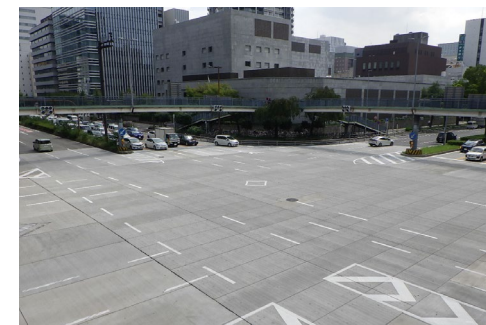
令和元年度19号丸の内地区舗装修繕工事
