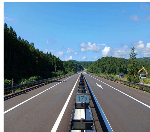
R6能越道穴水道路舗装復旧工事
