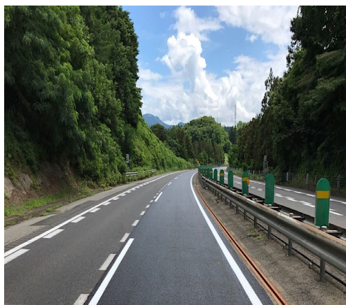
東北自動車道R6青森管内舗装補修工事
