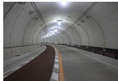
名塩道路城山トンネル舗装工事
