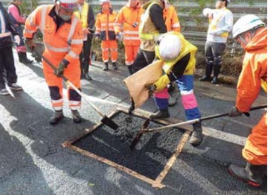
け運べるため、アスファルトプランまで取りに行く手間が省ける。通常のアスファルト舗設時の温度120～150度より30度低い約110度で施工できる。
