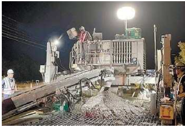
1DAY PAVEのスリップフォーム工法による施工
