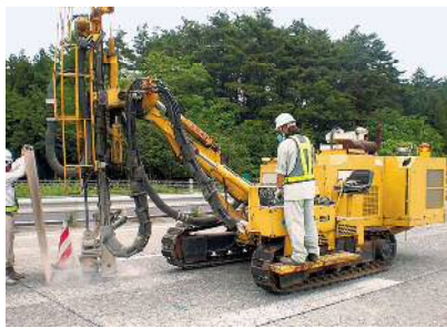
施工時はまずコンクリート版を削孔する
