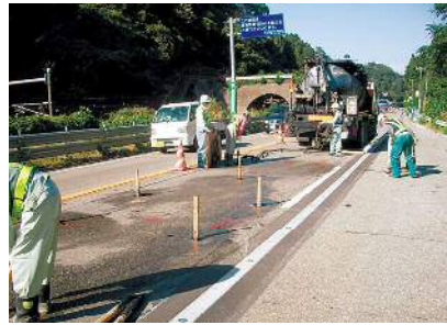
1日当たり約2000平方メートルの施工も可能
